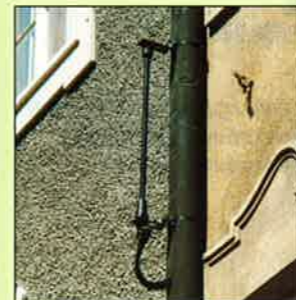
Mikrozelle an Dachrinne
